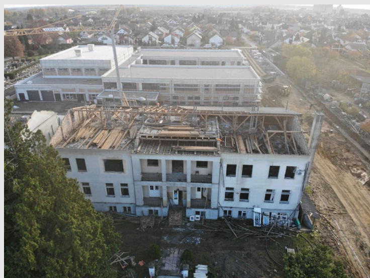
Stara u razgradnji, nova u izgradnji
