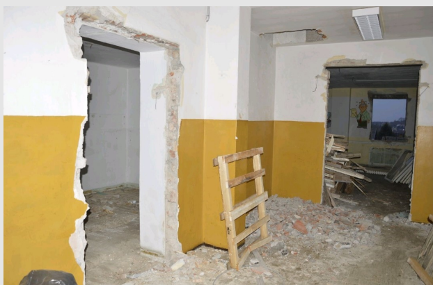
Razgrađivanje stare škole
